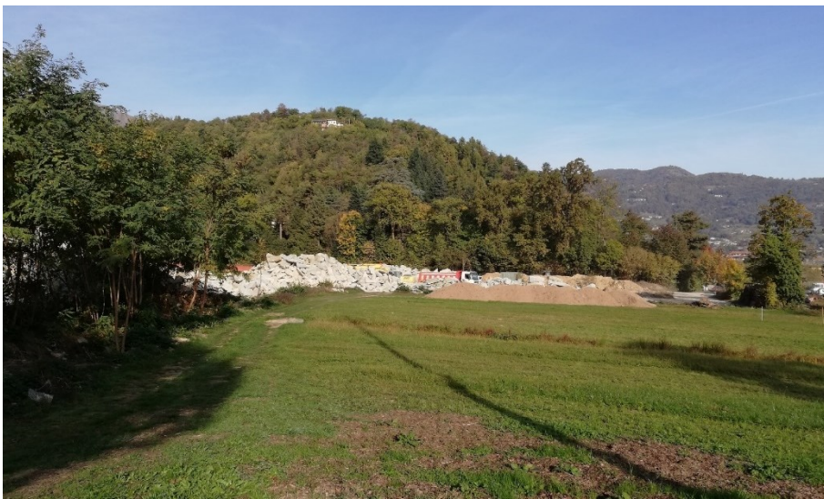
Fotografia dell'area D2 vista dal confine sud della stessa in prossimità della previsione urbanistica di PRGC di nuova viabilità
