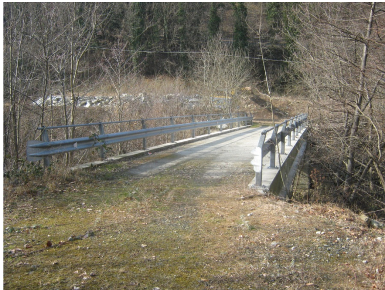
Vista impalcato del ponte sul Torrente Luserna PEGFPO009
