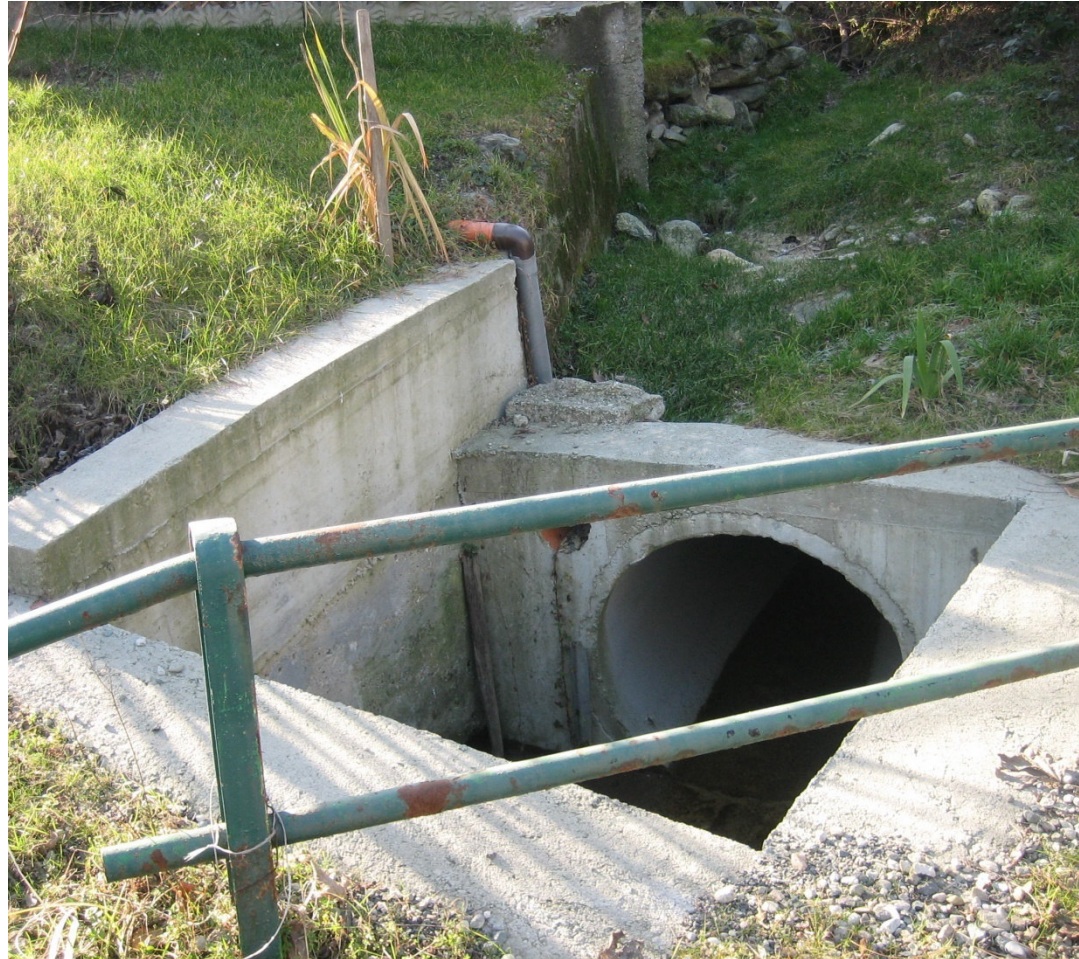
Vista da valle verso monte dell'attraversamento del Rio Cassere - PEGFPO011
