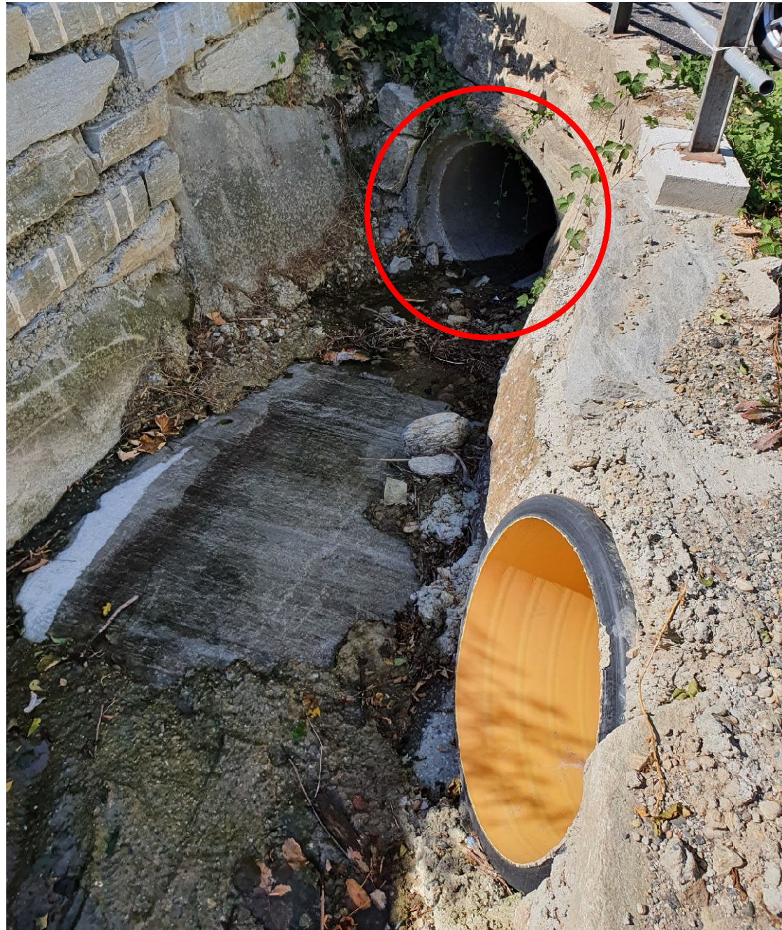
Vista da valle verso monte dell'attraversamento del Rio Comba La Losa - PEGFPO012
