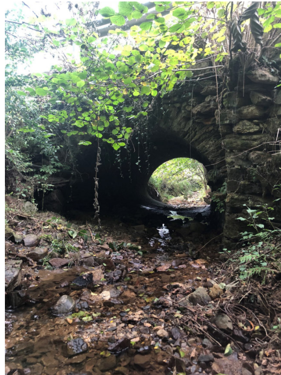
Vista da monte verso valle del ponte sul Rio Serbial PEGFPO003
